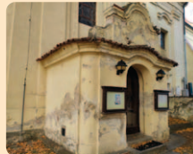
Rekonstrukce vstupního objektu do kostela.
