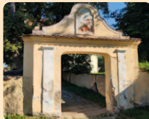
Oprava fasády a osazení mozaikového obrazu ve štítu vstupní brány do areálu kostela.
